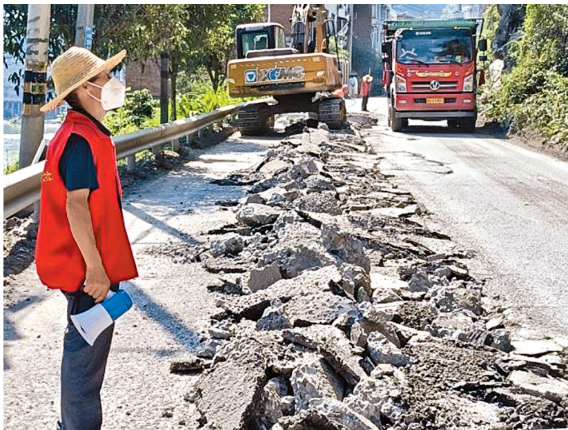
宣汉县樊哙镇金花村锁口庙至向家坝路段修复现场。(胡百顺 摄)
