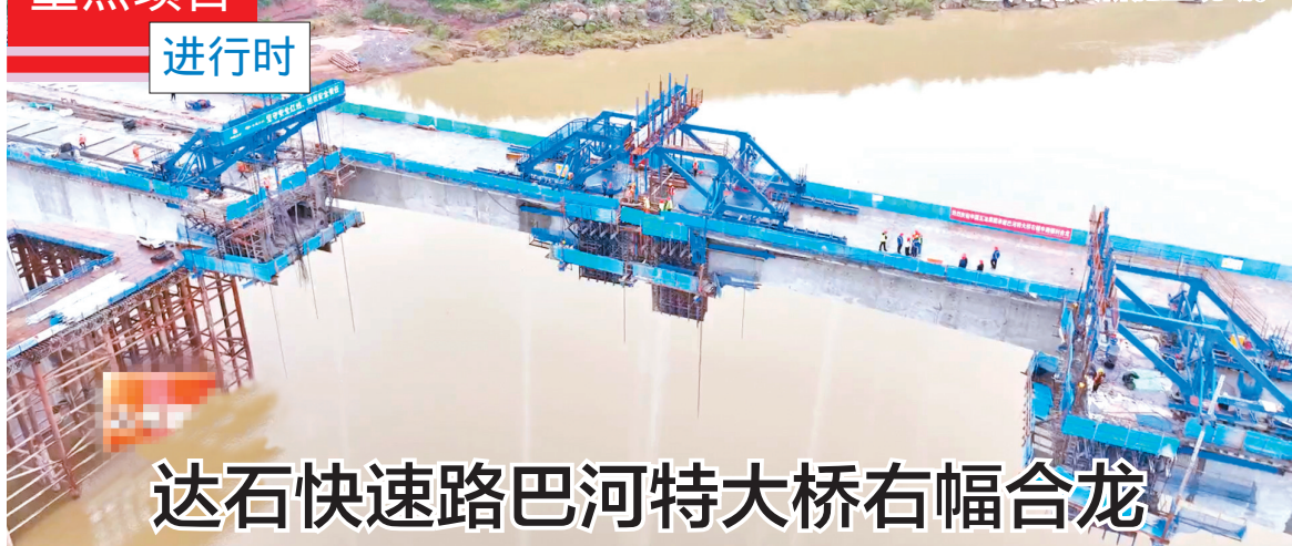
巴河特大桥施工现场。
